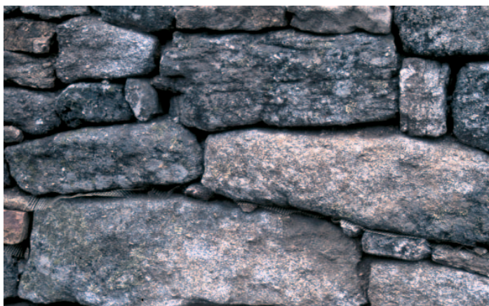
Ulaca. Detalle del aparejo de la muralla.
