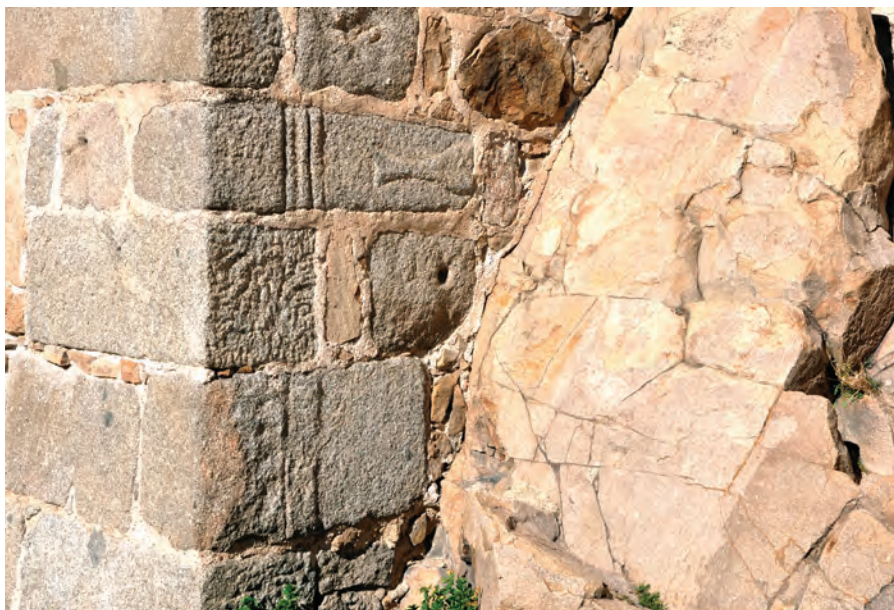
Figura 4. Aras embutidas en el cubo 71 de la muralla de Ávila correspondientes posiblemente al solar o a la fábrica de la antigua iglesia de San Román.
