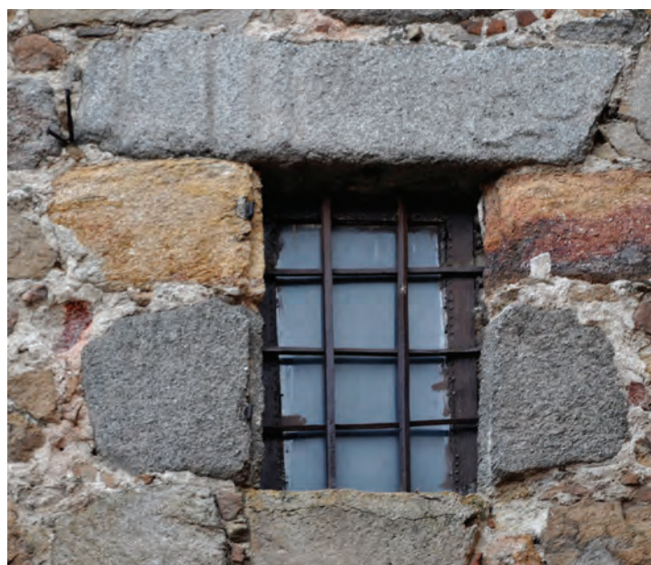
Figura 5. Ara en el dintel de una ventana del Palacio de los Dávila correspondientes posiblemente al solar o a la fábrica de la antigua iglesia de San Román.
