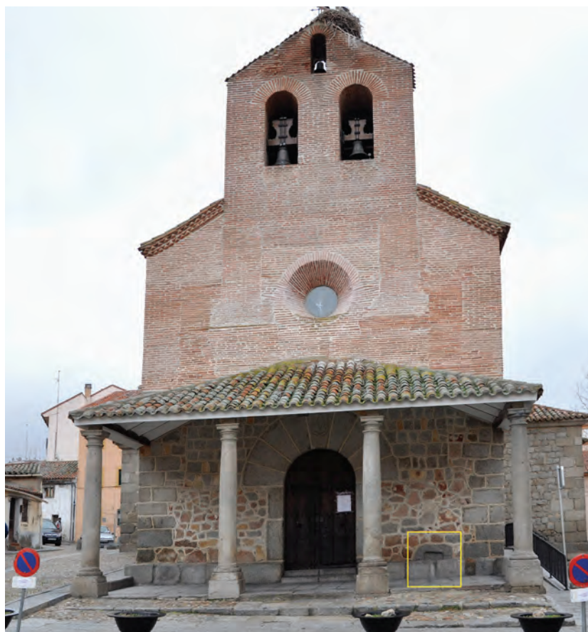
Figura 7. Ermita de Nª Sª de las Vacas. Cista en el aparejo de la iglesia.
